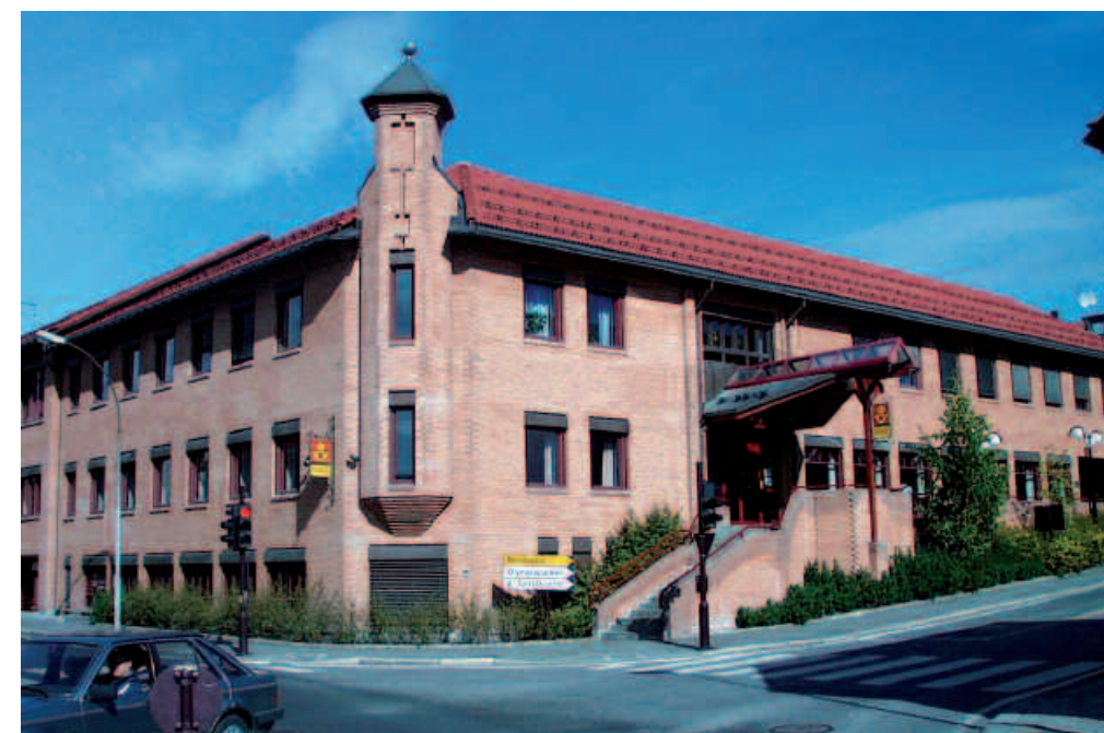
Til utformingen av Lillehammer postgård er det hentet inspirasjon fra bl.a. middelalderse festningsanlegg. Foto: Posten Norge
