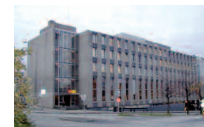
I hovedfasaden mot Haakon VIIIs gate er funksjonene godt lesbare; trapperommet markerer seg sterkt med det store glassfeltet, mens den doble vindushøyden viser den store ekspedisjonshallen. Foto: Posten Norge
