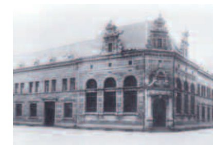
Bygningen var palassliknende med banklokaler på en av byens fremste hjørnetomter. Den var inspirert av renessansestil fra Christian 4.s tid. Posten fikk lokaler planlagt for sine formål i fløyen langs Markens gate til venstre og postmesteren fikk leilighet i 2. etasje. Foto: Postmuseet
