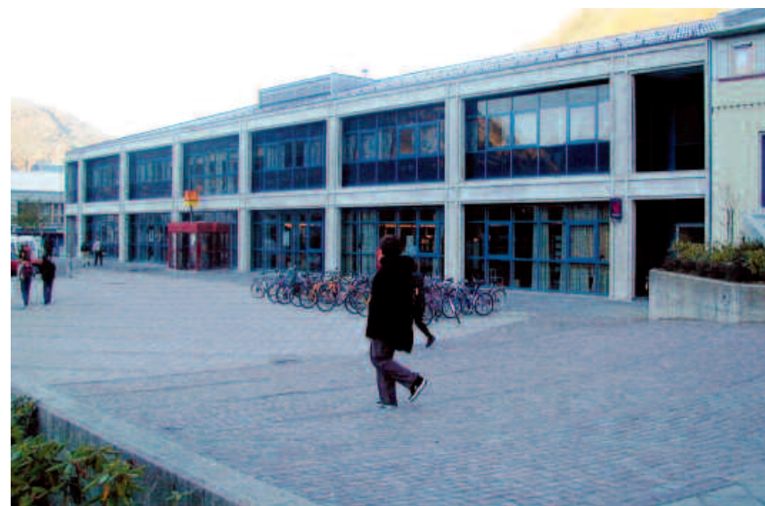
Bygningens strukturalistiske formspråk kunne tyde på at det var et betongelementbygg, mens det faktisk er oppført av plasstøpt betong. Foto: Posten Norge
