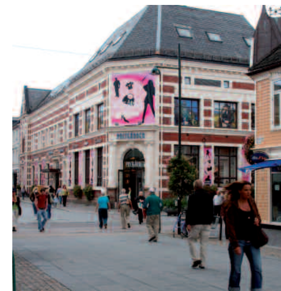
Kristiansand postgård med fasadene slik de i hovedsak ble etter ombygging og forenkling i 1938. Gavlene forsvant og etasjer der det opprinnelig var bankekspedisjon med ekstra stor takhøyde. Etter ny ombygging til kjøpesenter ca. 2003 er interiørene fullstendig fornyet, og Posten bruker bare et mindre areal inne i bygningen der det opprinnelig var gårds-plass. Foto: J.Chr. Eldal, NIKU, 2006
