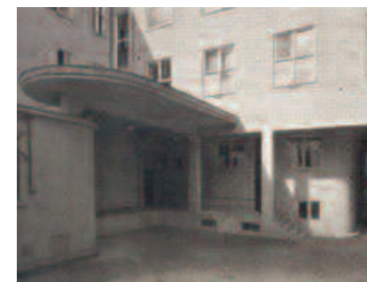
Overdekket lasterampe i gårdsrommet, med funksjonalismens buede takform. Foto: Byggekunst nr. 4 1938
