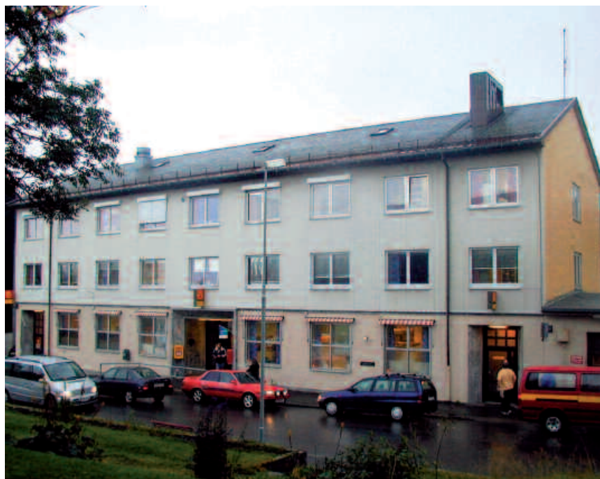
Hammerfest postkontors hovedfasade mot Storgaten. Med ny kledning av fasadeplater i 2. og 3. etasje fremstår bygningen noe annerledes enn da den ble bygget. Foto: Posten Norge
