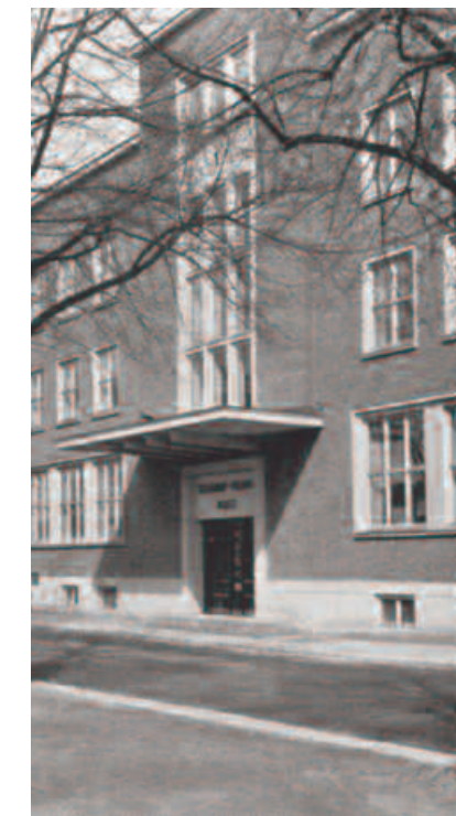
Bilder viser midtpartiet med overdekket inngangsparti og vindusfelt mot hovedtrapperom. Utkragete skivebaldakiner var et populært motiv og viser fascinasjonen for de nye mulighetene med armert betong. Foto: Byggekunst nr. 4, 1938
