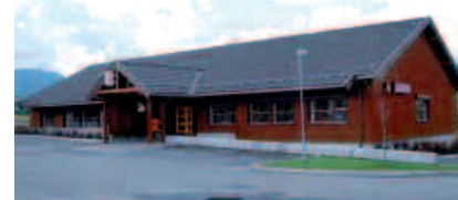
Bø postkontor fremstår som en lav og tung bygning, med en forholdsvis anonym karakter. Foto: SBED
