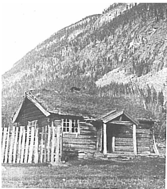
Knutslykkja før flytting.
